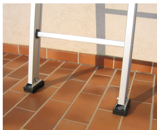
particolare gradini a piolo e dei piedini con suola in gomma antisdrucciolo alla base (mm 115 x 60)
